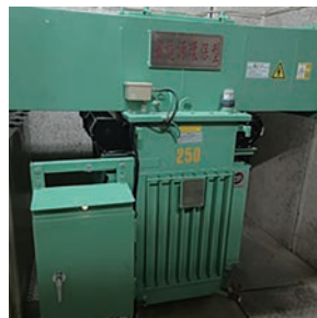
汽車廠變壓器汰換
