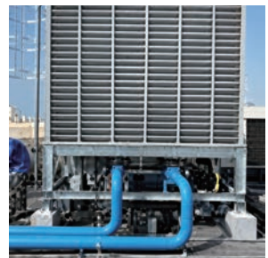
總部 250 噸冷卻水塔更新
